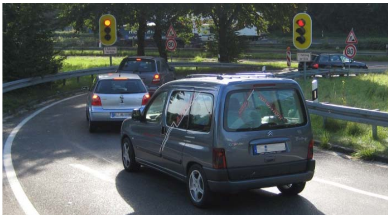
Bild 3-6: Zuflussregelung
