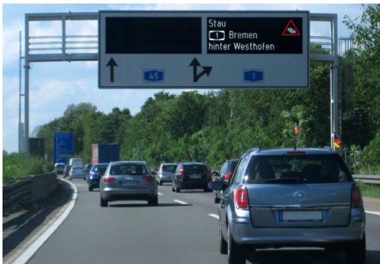
Bild 3-3: Dynamischer Wegweiser mit integrierten Stauinformationen (dWiSta)
