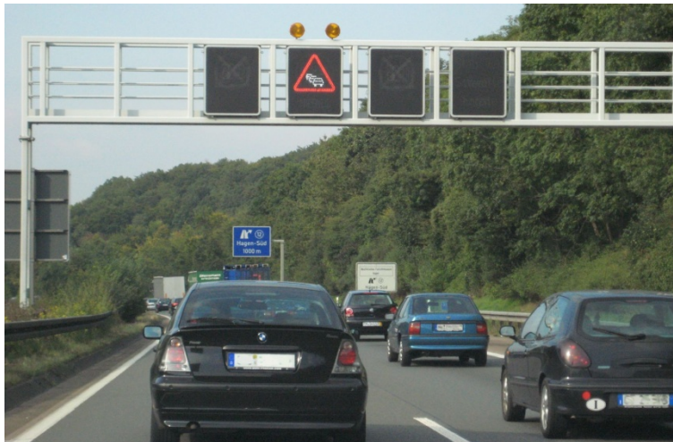
Bild 3-4: Streckenbeeinflussungsanlage
